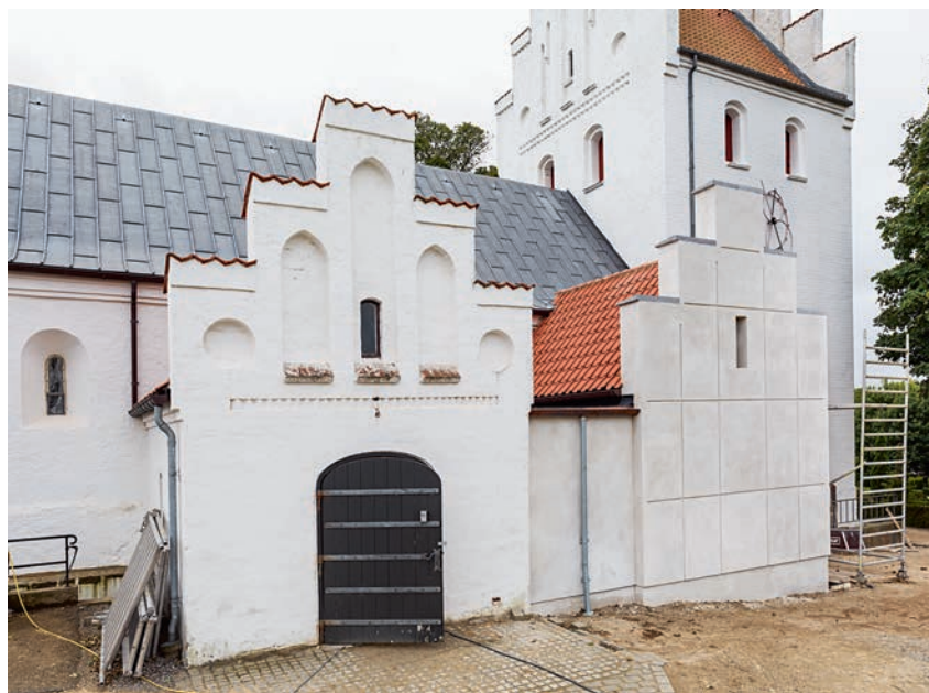
Fig. 59. Våbenhuset med tilbygning set fra nordnordøst (s. 2427). Foto Arnold Mikelsen 2016. – Porch with extension seen from north-north-west.
