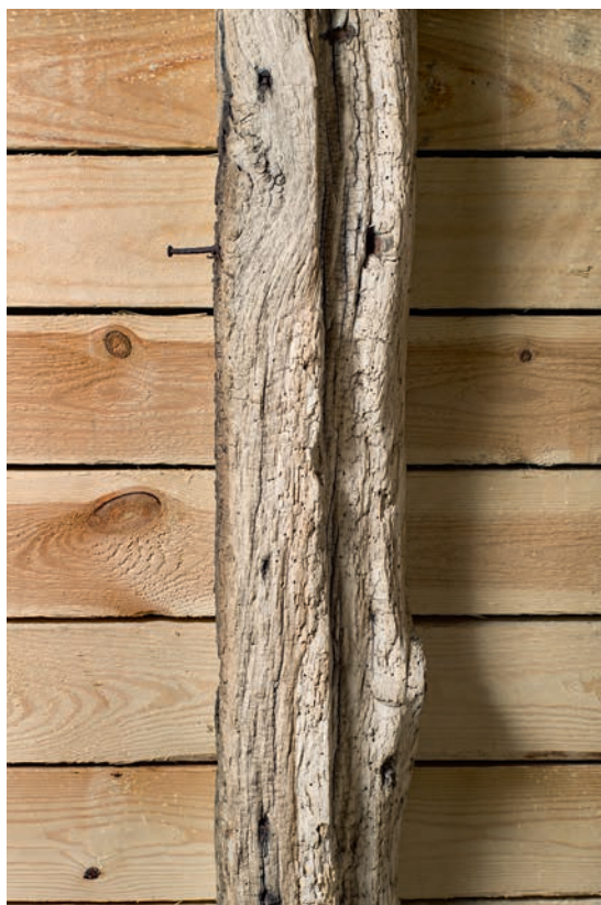
Fig. 15. Korets nordøstligste spær med hjørnefals, set fra syd (s. 2495). Foto Arnold Mikkelsen 2016. – Northeasternmost rafter of chancel with corner chamfering, seen from the south.
