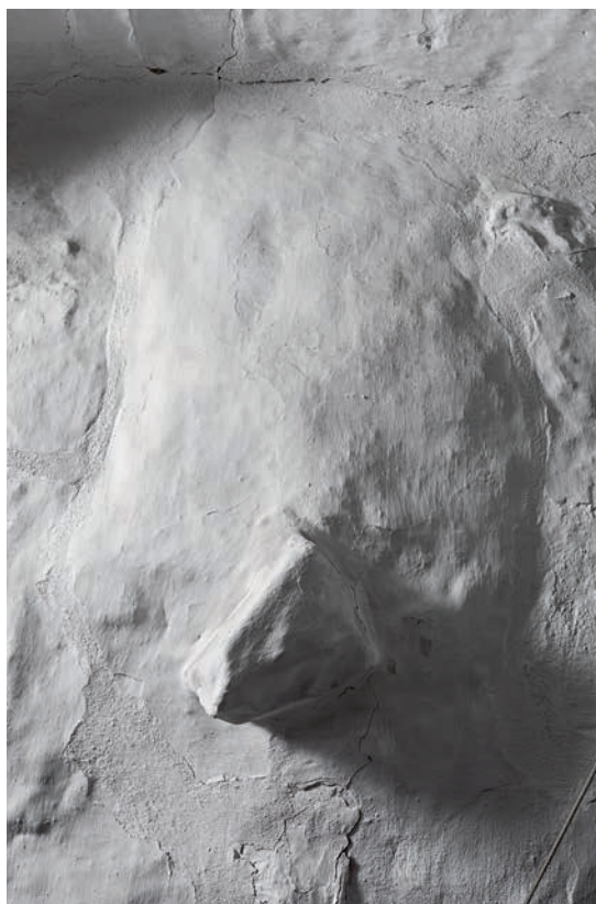
Fig. 46. Tilmuret romansk vindue i korets østgavl, set fra vest (s. 2494). Foto Arnold Mikkelsen 2016. – Walled-up Romanesque window in east gable of chancel.
