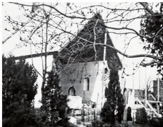
Fig. 13. Koret under istandsættelse set fra sydøst 1939 (s. 2567). Foto Brande Arkiv. – The chancel during repairs.
