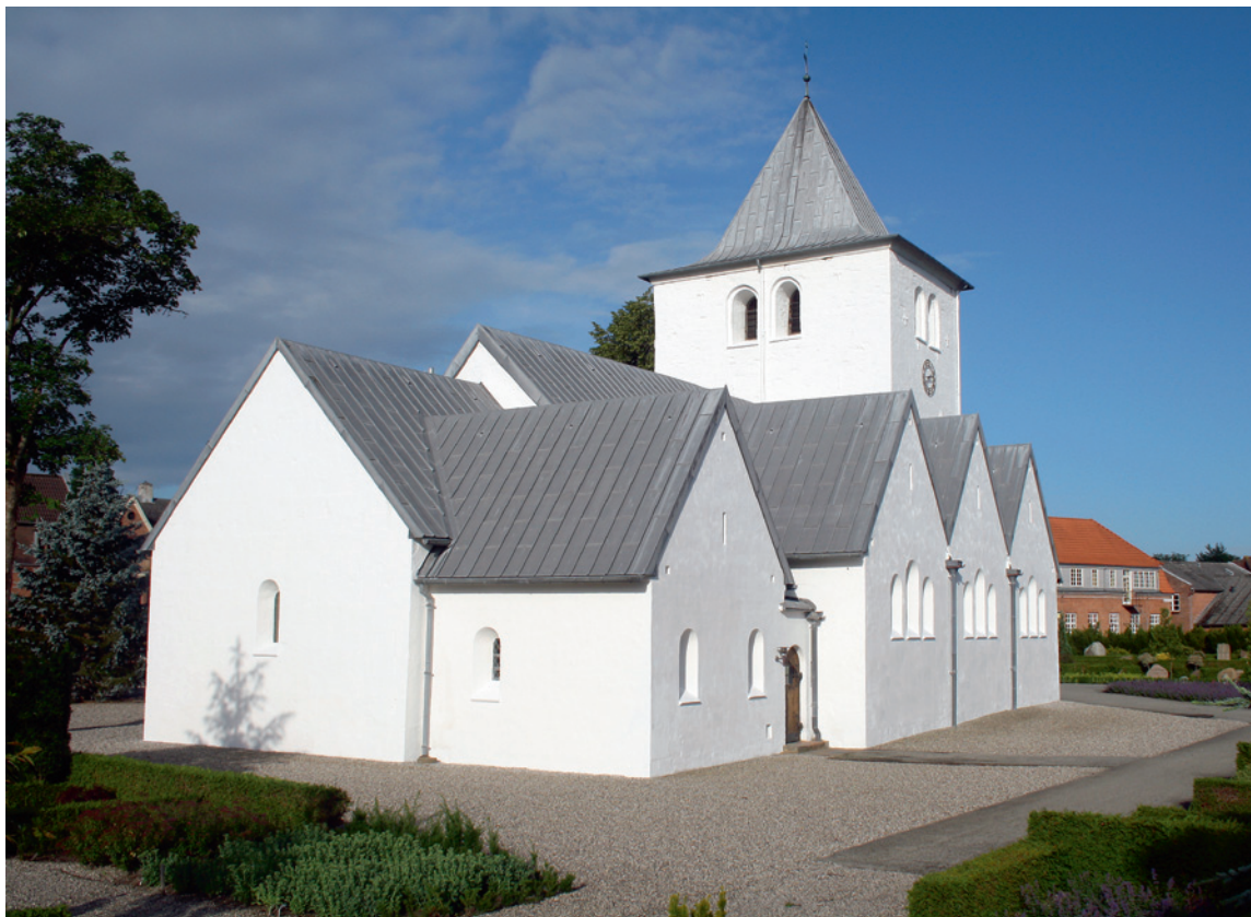
Fig. 66. Kirken set fra nordøst. Foto Ebbe Nyborg 2016. – The church seen from the north east.
