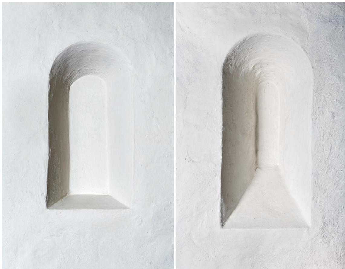
Fig. 6-7. Tilmurede vinduer (s. 2558). 6. I korets nordvæg. Foto Arnold Mikkelsen 2016. 7. I skibets sydvæg. Foto Arnold Mikkelsen 2017. – Bricked-up windows. 6. In the north wall of the chancel. 7. In the south wall of the nave.
