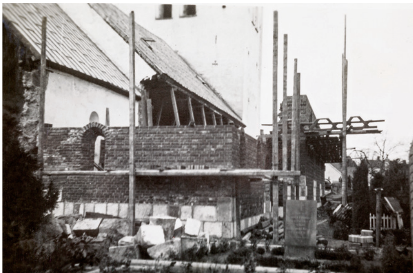
Fig. 12. Sakristi og sideskibe under opførelse, set fra nordøst (s. 2566). Foto Brande Arkiv. – Sacristy and side aisles during construction, seen from the north east.
