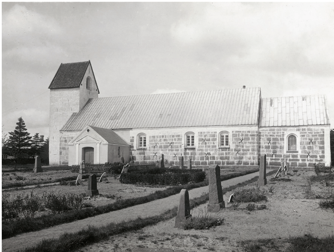
Fig. 4. Kirken set fra syd med \dagger våbenhus, nedtaget 1949 (s. 2641). Foto o. 1900 i NM. – The church seen from the south with the \dagger porch taken down in 1949.
