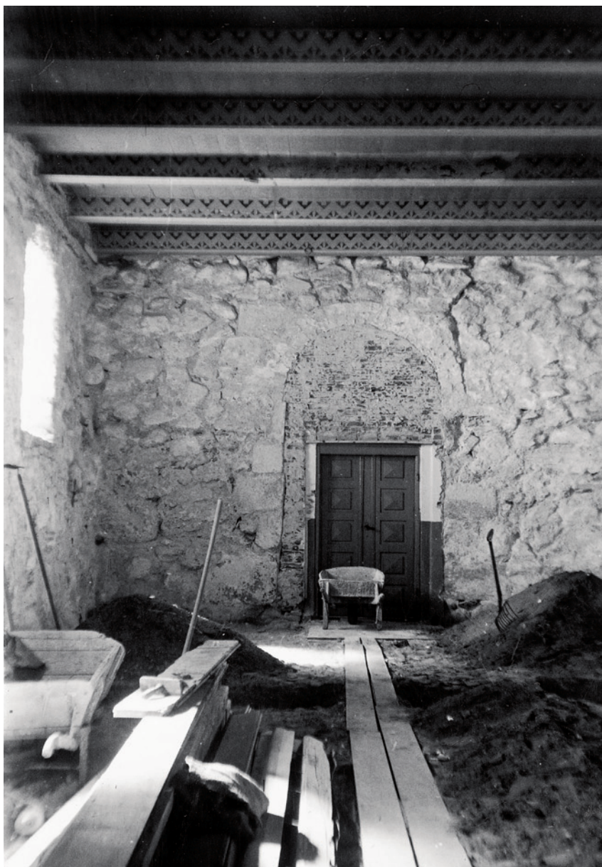
Fig. 10. Vestvæggen i det forlængede skib med arkade til tårnet (s. 2636). Foto under restaureringen 1949 ved E. og F. M. R. Draiby. – The west wall of the lengthened nave with an arcade to the tower.
