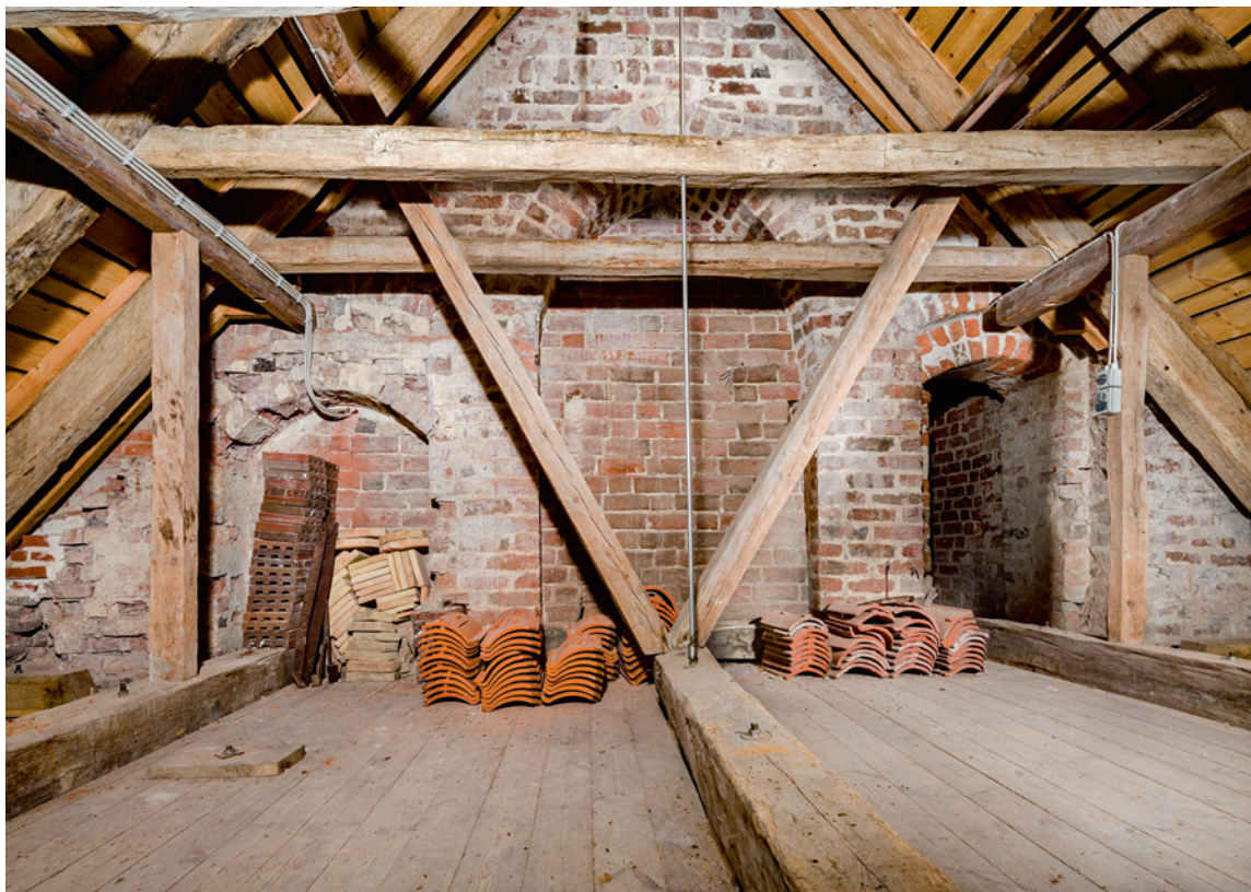
Fig. 18. Skibets vestre gavltrekan set mod vest (s. 2814). Foto Arnold Mikkelsen 2018. – Western pediment of the nave looking west.
