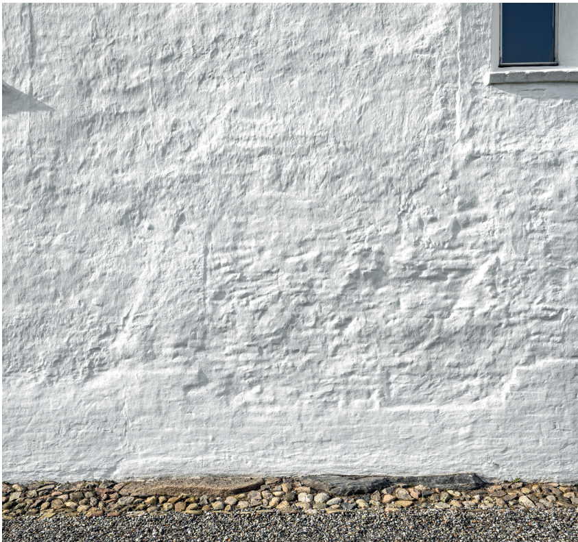
Fig. 50. Skibets †nordportal (s. 3043-44). Foto Inger Marie Helgasdatter Mulvad 2021. – North †portal of the nave.
