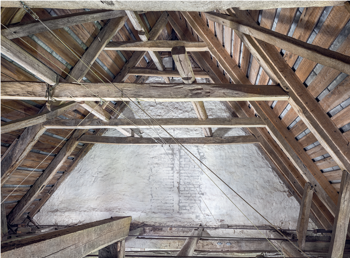
Fig. 56. Tilmuret glamhul i tårnets nedskårne vestmur, set fra øst i det nuværende klokkestokværk (s. 3054). Foto Inger Marie Helgasdatter Mulvad 2021. – Bricked-up belfry light in the cut-down west wall of the tower, seen from the east on the present belfry floor.
