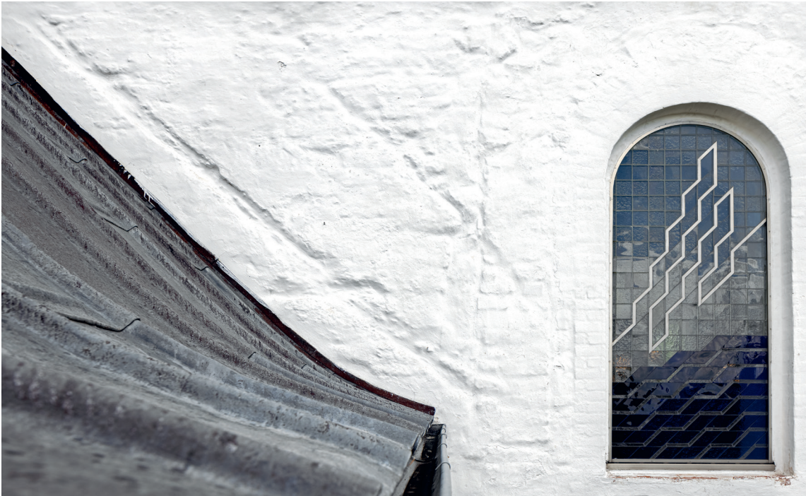
Fig. 146. Skibets sydside med tagspor efter ældre \ddagger våbenhus (s. 3057) og spor af ældre \ddagger vindue (s. 3054–55). Foto Inger Marie Helgasdatter Mulvad 2019. – The south side of the nave with traces of an older \ddagger porch and traces of an older \ddagger window.
