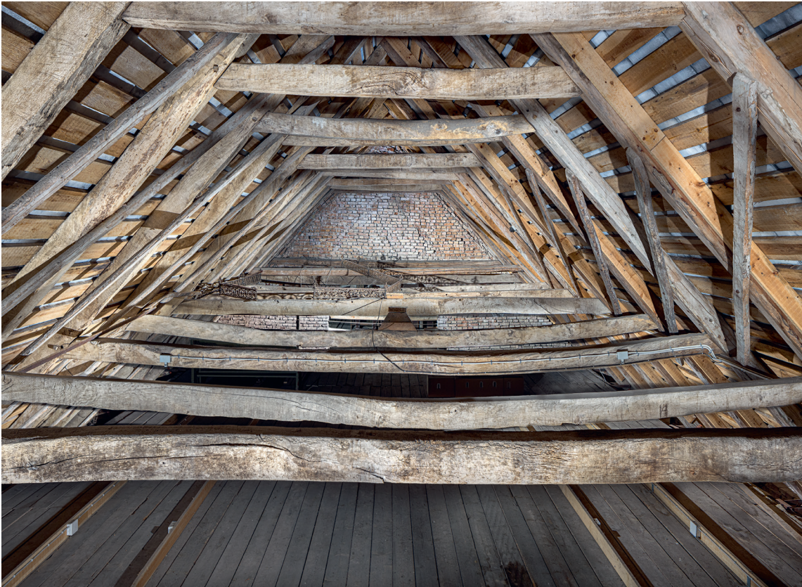
Fig. 66. Skibets tagkonstruktion set mod øst (s. 3065). Foto Inger Marie Helgasdatter Mulvad 2021. – The roof construction of the nave looking east.
