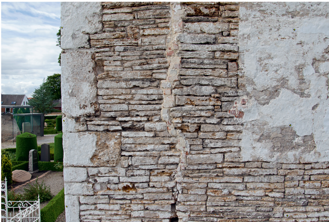
Fig. 47. Sammenstød mellem oprindeligt og repareret frådstensmurværk på den afrensede korgavls øvre søndre del. Foto Stine A. Højbjerg 2012. – Meeting of original and repaired calcareous tufa masonry on the remaining southern part of the trimmed chancel gable.
