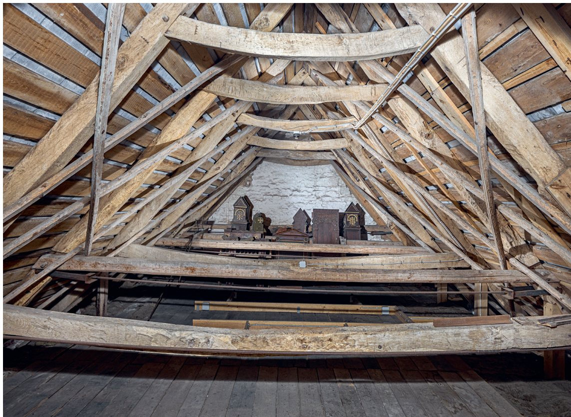
Fig. 65. Korets tagkonstruktion set mod øst (s. 3065). Foto Inger Marie Helgasdatter Mulvad 2021. – The roof construction of the chancel looking east.
