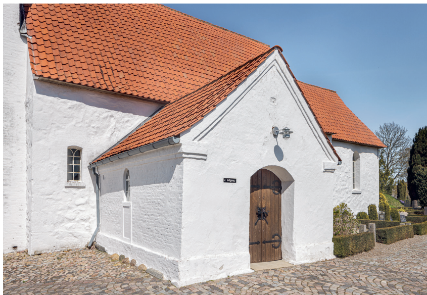
Fig. 20. (†)Våbenhuset set fra sydvest (s. 3681). Foto Arnold Mikkelsen 2022. – The porch from the south-west.
