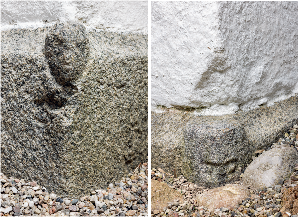
Fig. 9-10. 9. Detalje af korets sokkel, nordøsthjørne (s. 3673). 10. Detalje af skibets sokkel, nordvesthjørne (s. 3673). Foto Arnold Mikkelsen 2022. — 9. Detail of the plinth of the chancel, north-east corner. 10. Detail of the plinth of the nave, north-west corner.
