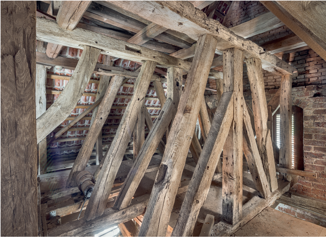
Fig. 22. Klokkestol, af egetømmer fældet o. 1418 (s. 3688). Foto Arnold Mikkelsen 2022. – Bell frame, of oak timbers felled c. 1418.
