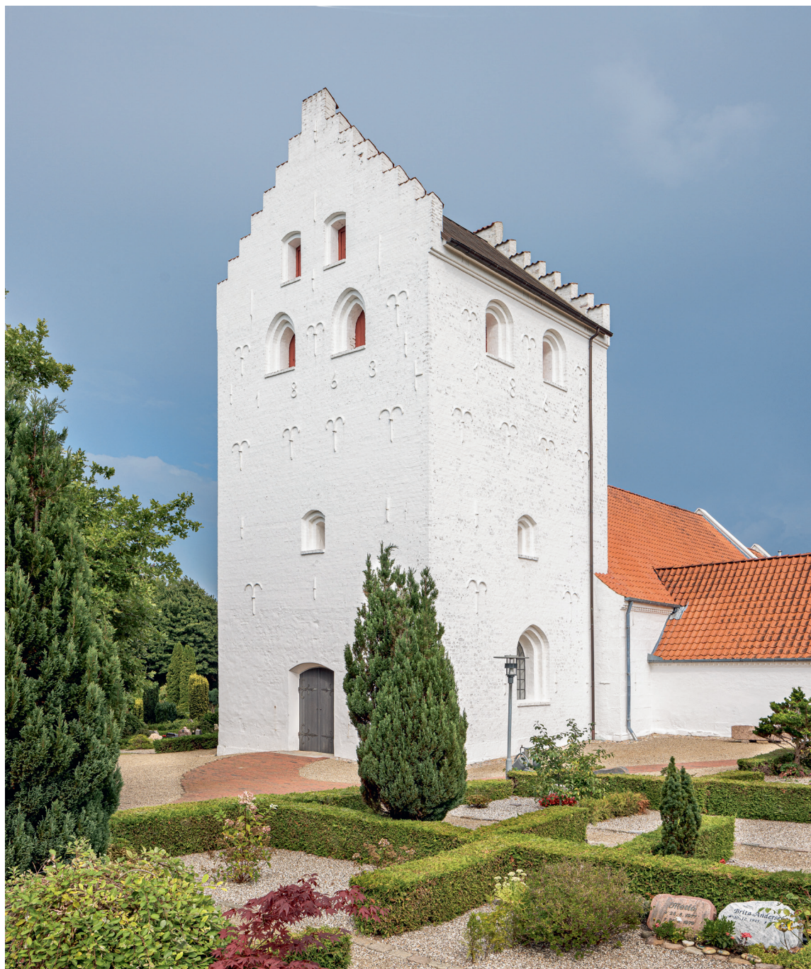
Fig. 19. Tårnet set fra sydvest (s. 3742). Foto Arnold Mikkelsen 2022. – The tower seen from the south-west.
