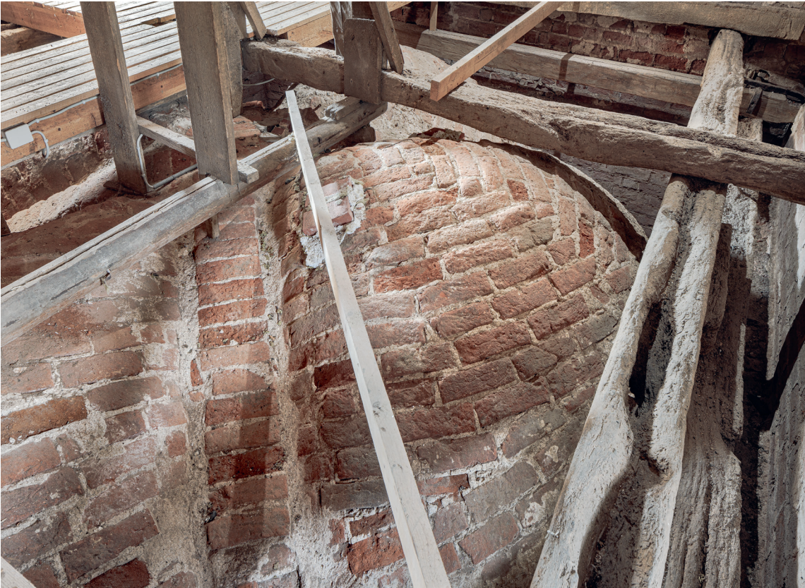
Fig. 21. Tårnhvælvets overside set mod sydvest (s. 3743). Foto Arnold Mikkelsen 2022. – The upper side of the tower vault looking south-west.
