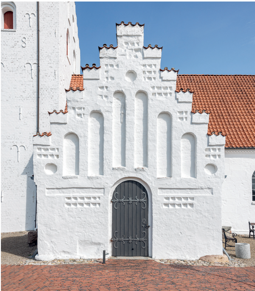
Fig. 17. Våbenhuset set fra syd (s. 3741). Foto Arnold Mikkelsen 2022. – The porch seen from the south.
