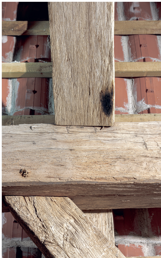
Fig. 31. Detalje af skibets tagværk med brændemærke (s. 3776). Foto Arnold Mikkelsen 2022. – Detail of the roof structure of the nave with burnmark.
