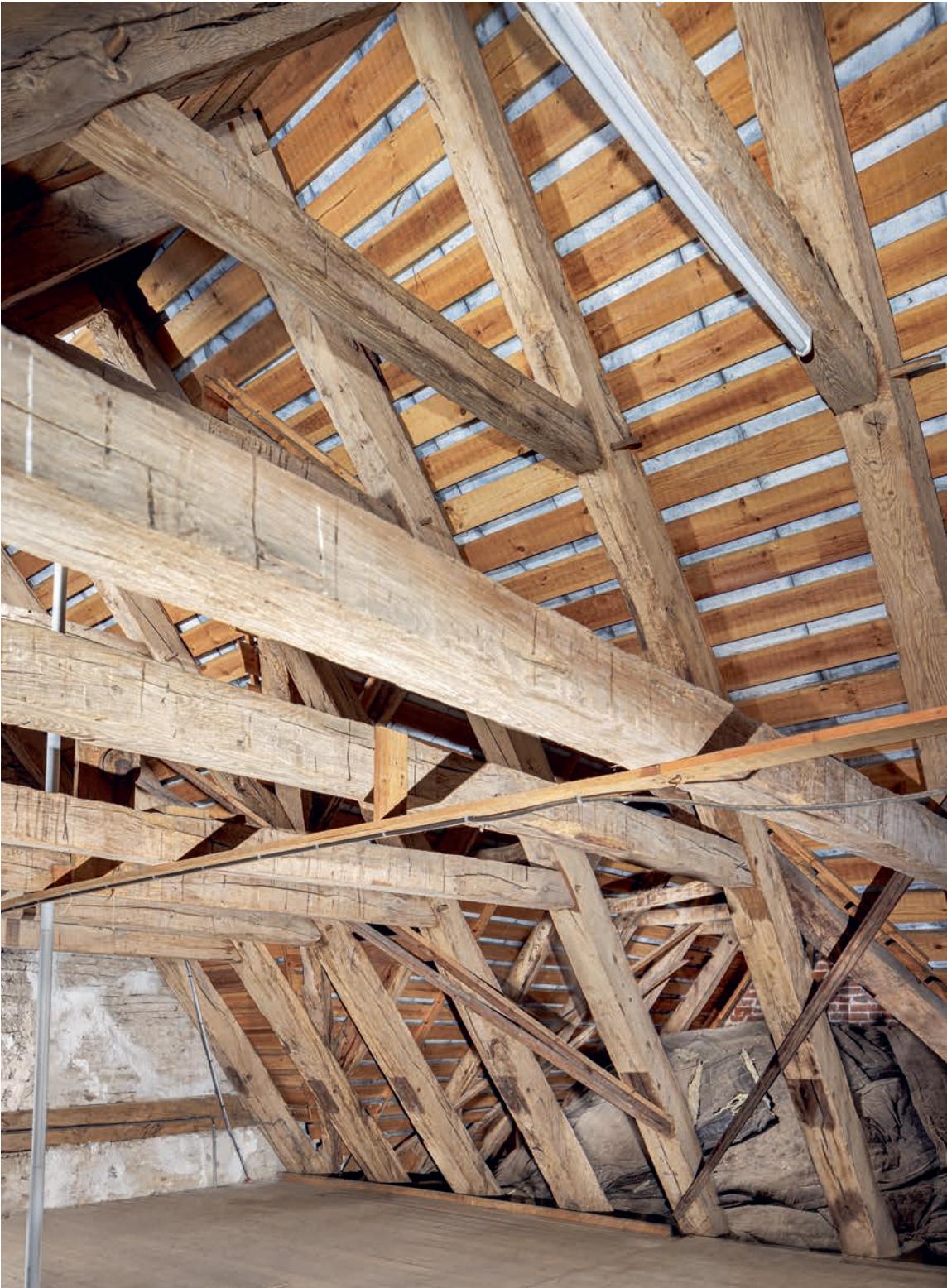
Fig. 20. Korets tagværk, o. 1440 (s. 3818). Foto Arnold Mikkelsen 2022. – The roof structure of the chancel, c. 1440.
