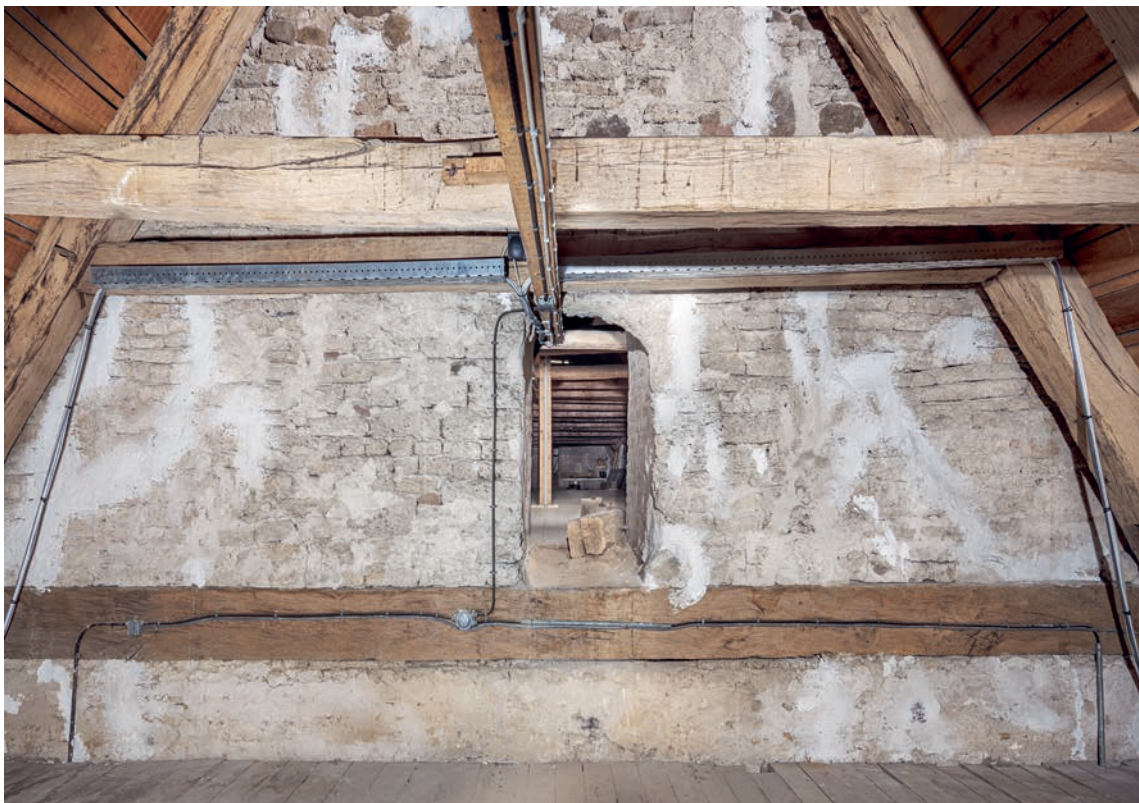
Fig. 21. Triumfmurens gavltrekan set mod vest med bindbjælke o. 1137 fra skibets oprindelige gavlsparfag (s. 3819). Foto Arnold Mikkelsen 2022. – The chancel arch wall gable triangle looking west with tie beam c. 1137 from the nave's original gable truss.
