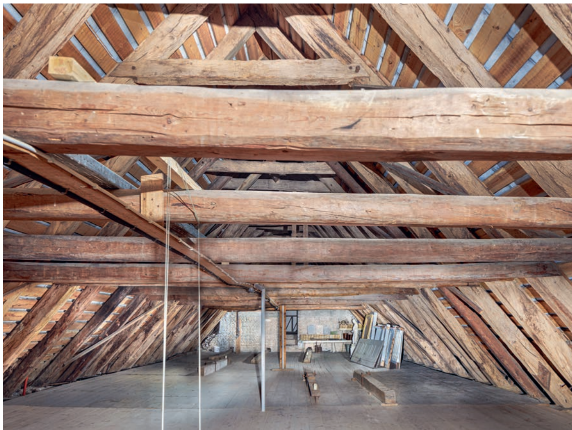
Fig. 24. Skibets tagværk set mod vest (s. 3818). Foto Arnold Mikkelsen 2022. – The roof structure of the nave looking west.
