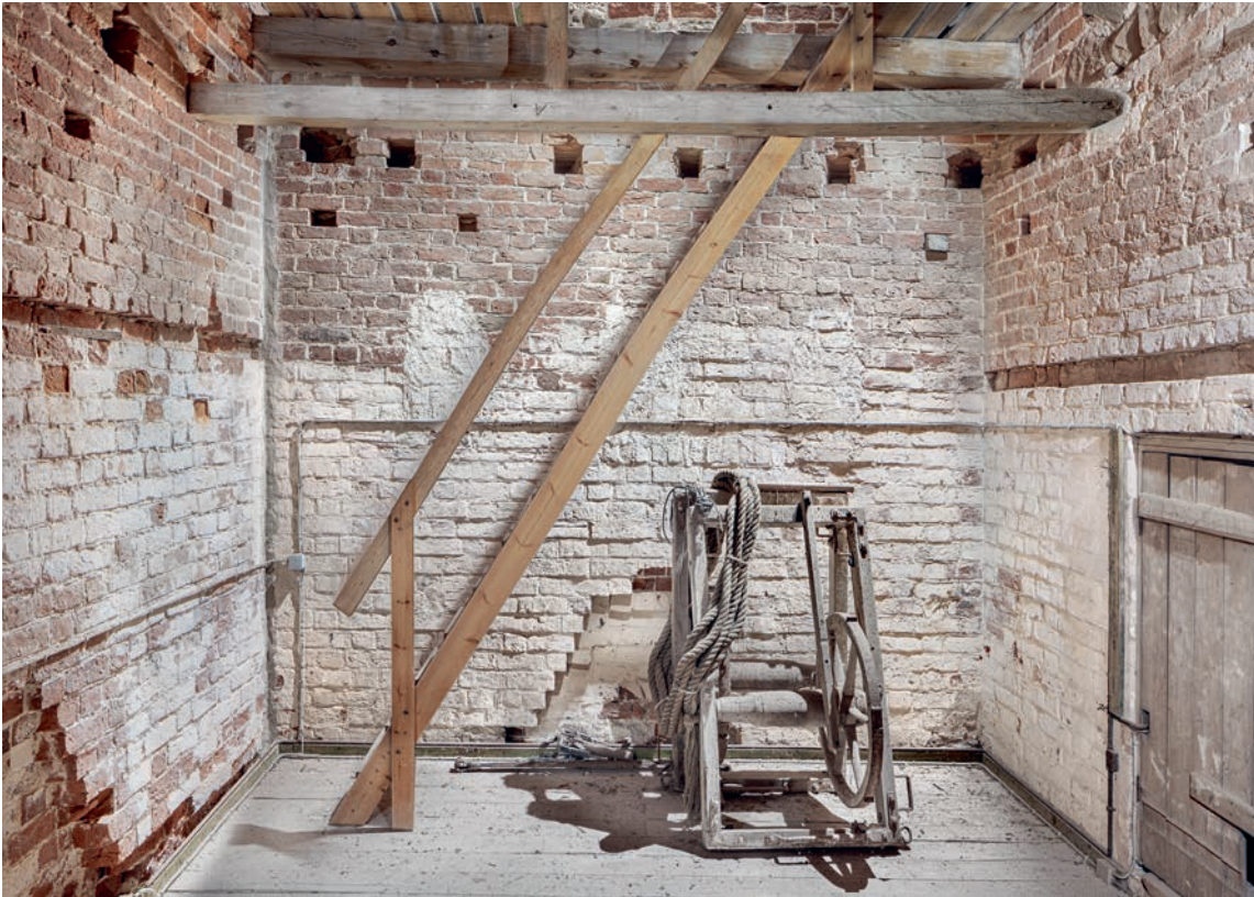
Fig. 9. Tårnets mellemstokværk set mod nord (s. 3959) samt henstillede dele af kalkevogn (s. 3966). Foto Arnold Mikkelsen 2023. – The middle floor of the tower looking north with parts of a limewashing apparatus.
