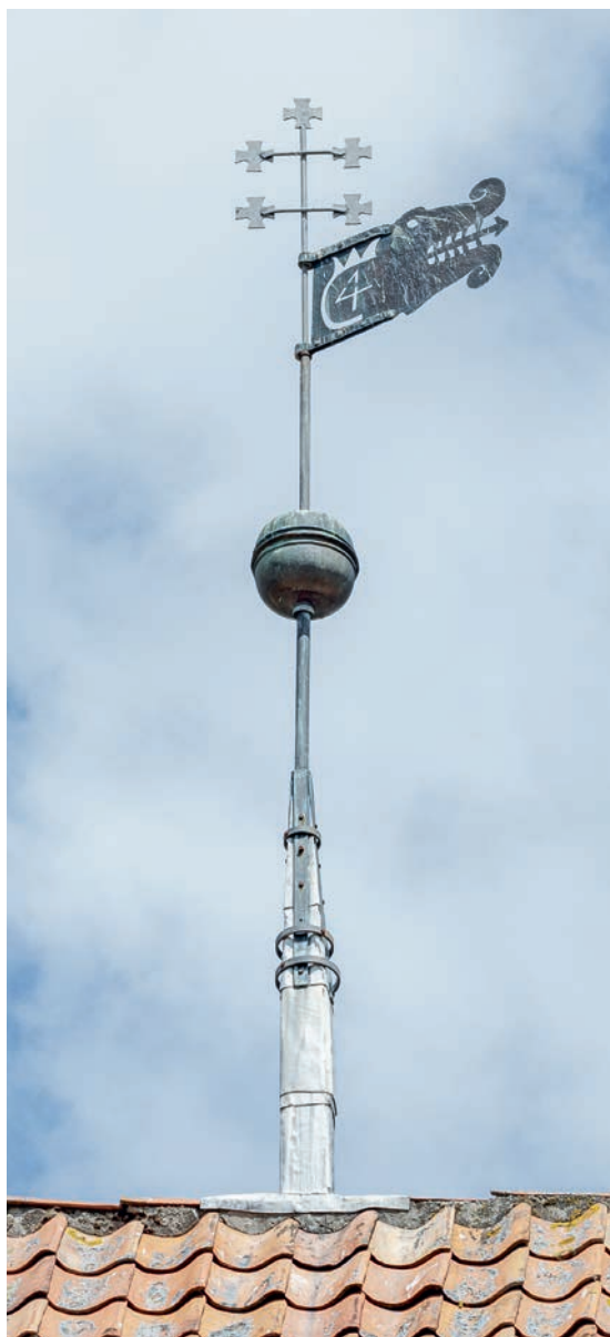
Fig. 15. Tårnets vindfløj (s. 3966). Foto Arnold Mikelsen 2023. – The tower's wind vane.
