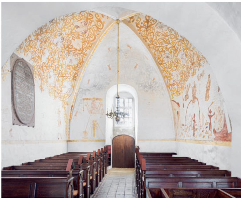
Fig. 38. Sydkapellets indre set mod syd (s. 4019 og 4034). Foto Arnold Mikkelsen 2023. – Interior of the southern chapel looking south.
