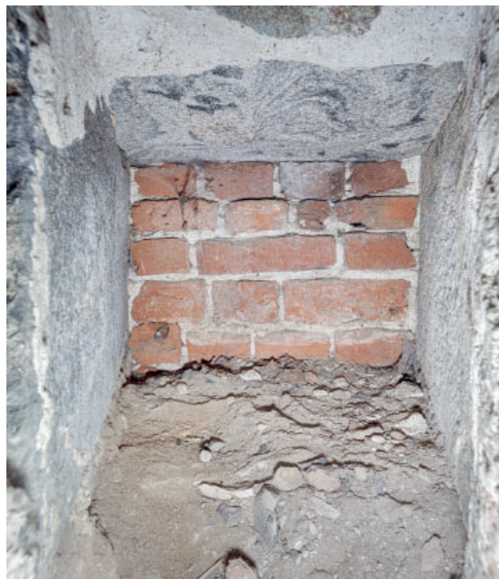
Fig. 15. Hagioskopets indvendige kvadersatte karme og lofi. Lukket med munkesten (s. 4014). Foto Arnold Mikkelsen 2023. – The interior ashlar frame of the hagioscope. Bricked up with medieval brick.
