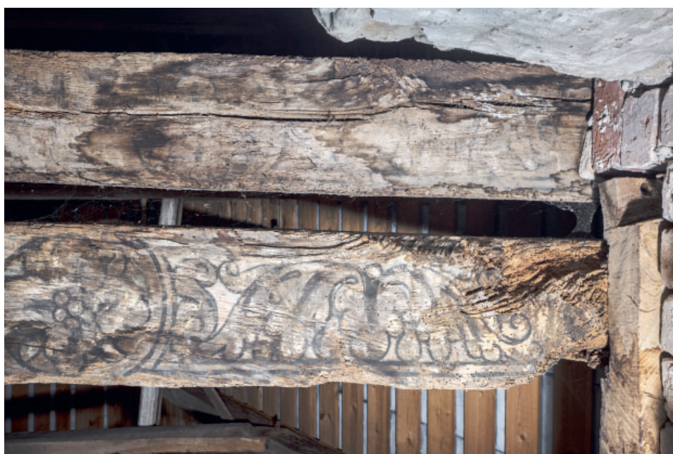
Fig. 30. Korets vestligste bindbjælker med bemaling (s. 4029). Foto Arnold Mikkelsen 2023. – The chancel's westernmost tie beams with paintwork.
