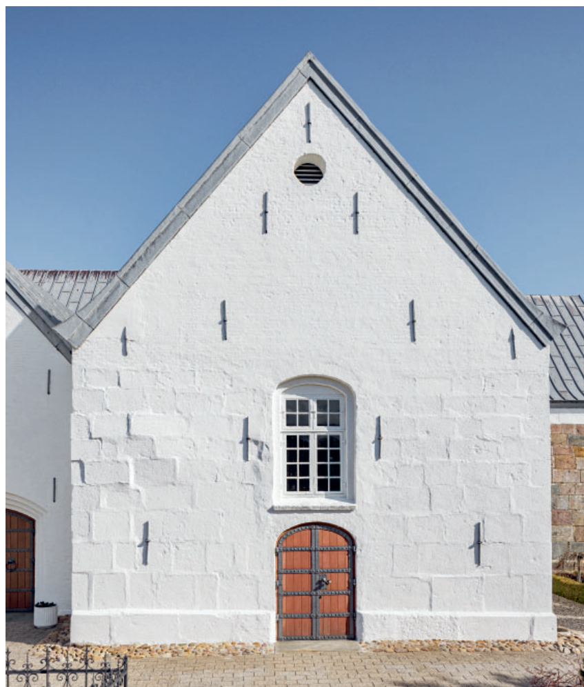
Fig. 20. Kapellets sydgavl (s. 4019). Foto Arnold Mikkelsen 2023. – Southern gable wall of the chapel.
