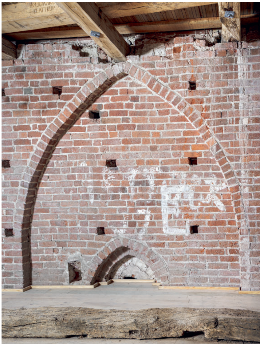
Fig. 19. Aflastningsbue med blændet åbning, der strækker sig under stokværkets gulv (s. 4018). Set mod nord. Foto Arnold Mikkelsen 2023. – Relieving arch with recessed opening, placed under the tower's upper floor. Looking north.
