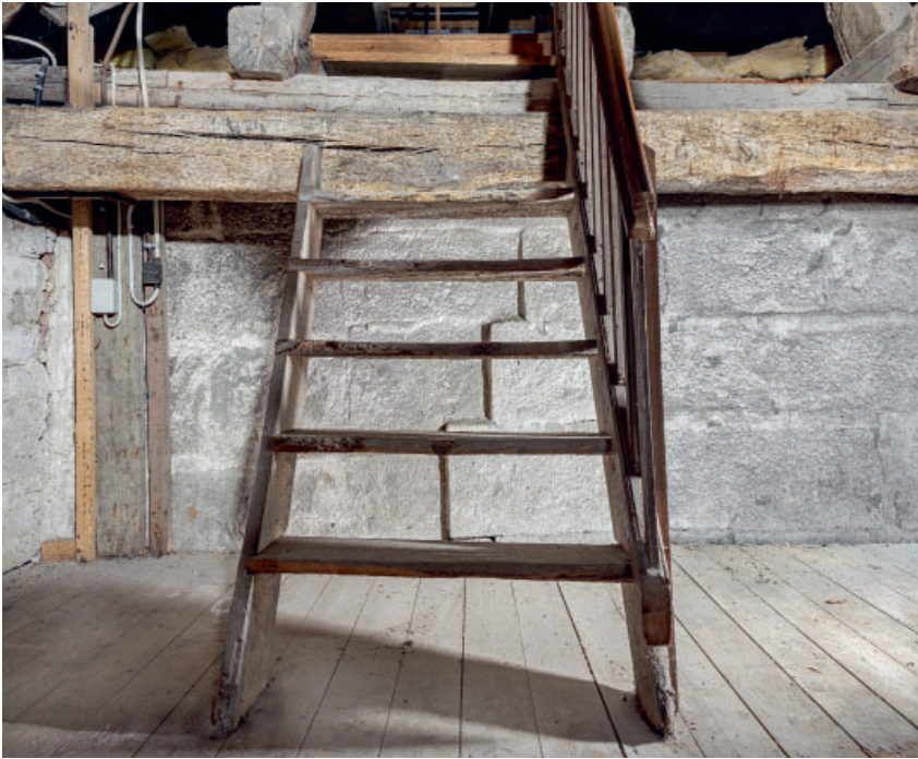
Fig. 122. Parti af skibets kvadersatte sydmur med lodfuge, der markerer vestforlængelsen (s. 4016). Set fra våbenhusets loft. Foto Arnold Mikkelsen 2023. – Part of the nave's southern ashlar wall with joint marking the west extension. Seen from the loft of the porch.
