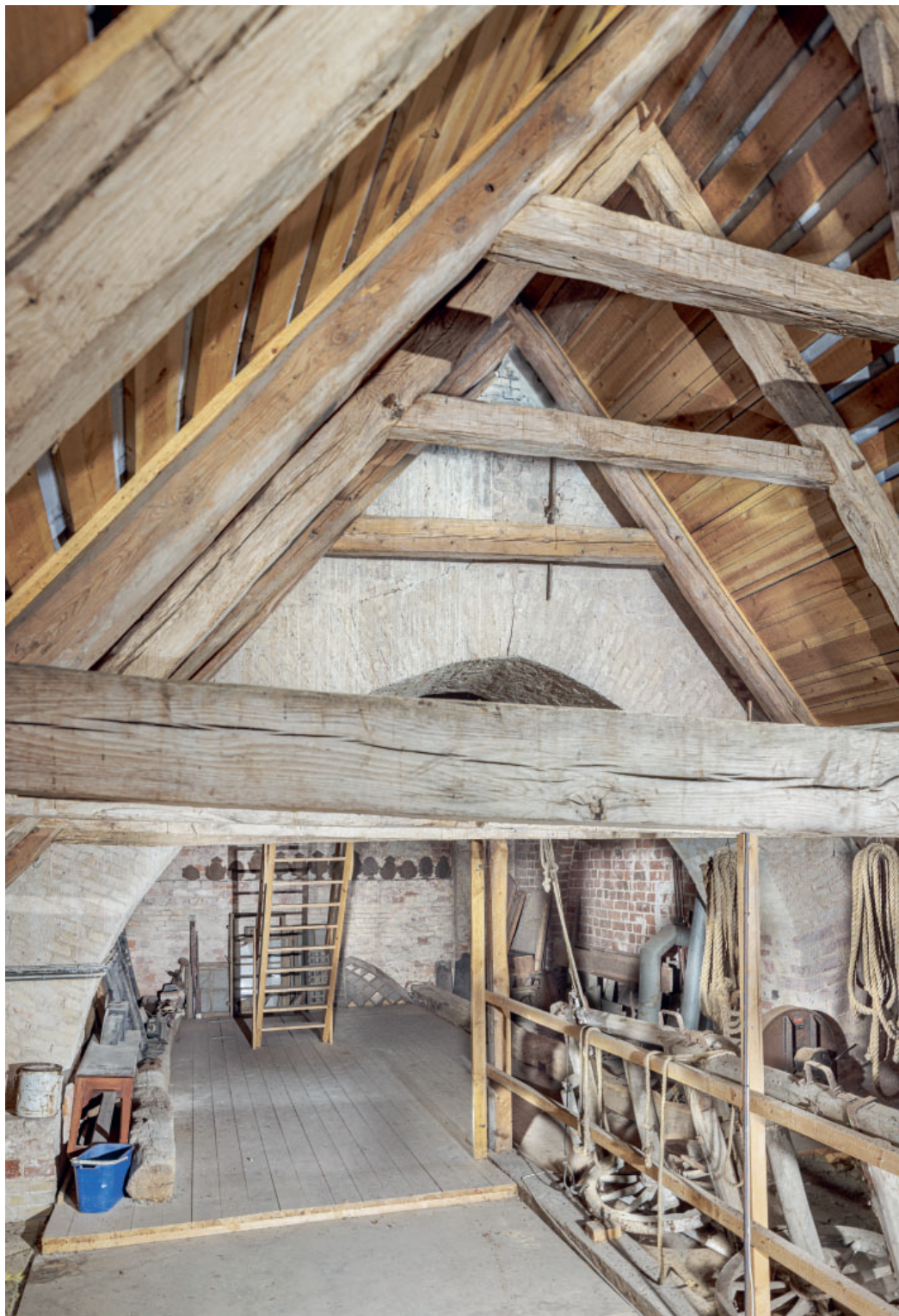
Fig. 26. Skibets tagværk (s. 4026) og tårnets mellemstokværk (s. 4018) set mod vest, samt kalkevogn nr. 1 (s. 4029). Foto Arnold Mikkelsen 2023. – Nave rafters and tower interior looking west.
