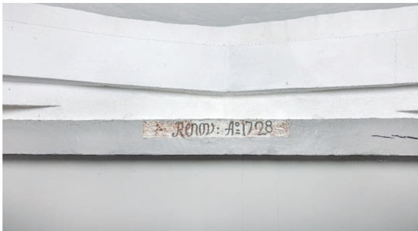
Fig. 29. Skibets vestligste loftsbjælke med påmalet restaureringsdatering (s. 4112). Foto Arnold Mikkelsen 2023. – The westernmost ceiling beam of the nave with date of restoration written in paint.
