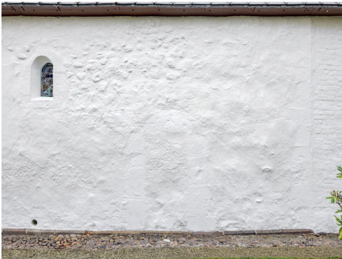
Fig. 17. Vestre vindue i skibets nordmur (s. 4104), den tilmurede \dagger norddør (s. 4103), samt overgangen mellem skib og vestforlængelse (s. 4106). Foto Arnold Mikkelsen 2023. – Western window in the north wall of the nave, the bricked-up \dagger north door, and the transition between the nave and the western extension.
