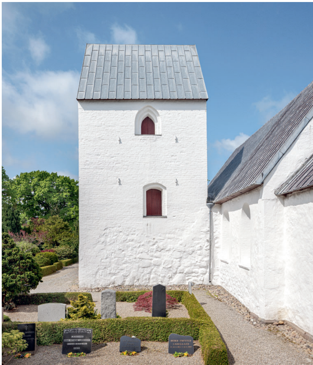
Fig. 23. Tårnet set fra øst, med (†)overdør (s. 4110). Foto Arnold Mikkelsen 2023. – The tower seen from the east, with (†)door.
