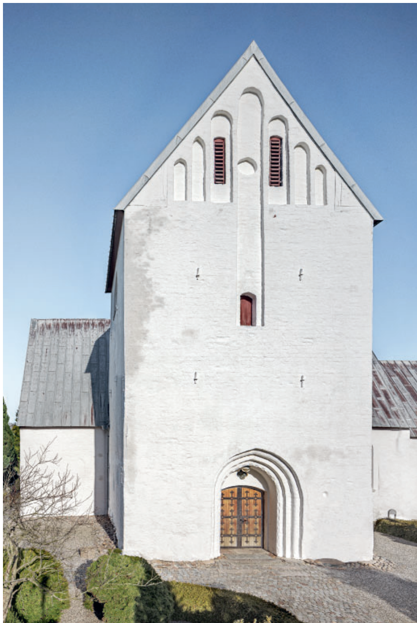
Fig. 22. Tårnet set fra syd (s. 4108). Foto Arnold Mikkelsen 2023. – The tower seen from the south.
