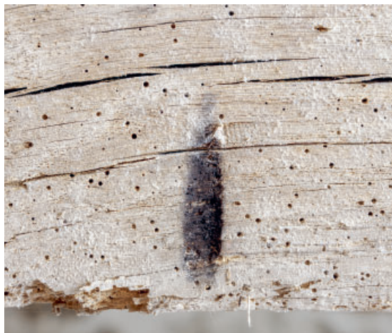
Fig. 32. Detalje af korets tagværk med brændemærke (s. 4116). Foto Arnold Mikkelsen 2023. – Detail of the chancel rafters with scorch mark.
