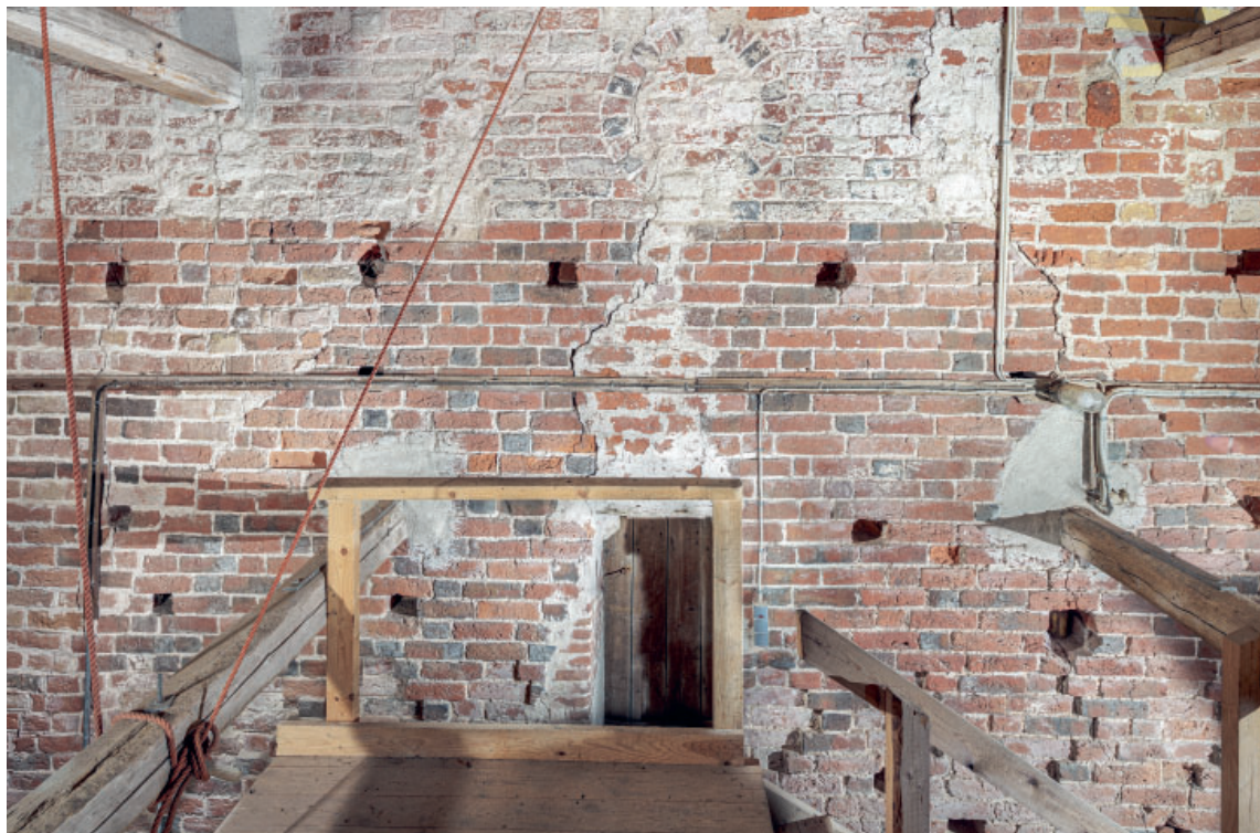
Fig. 16. Vestforlængelsens vestgavl set fra tårnet (s. 4168). Foto Arnold Mikkelsen 2023. – The western extension's west gable seen from the tower.
