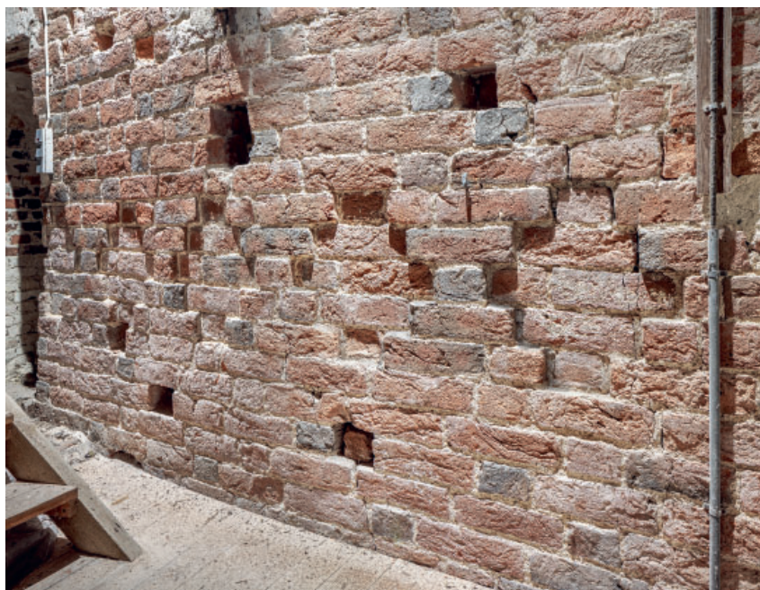
Fig. 17. Murblandinger i vestforlængelsens vestgavl (s. 4169). Foto Arnold Mikkelsen 2023. – Wall recesses in the western extension's west gable.
