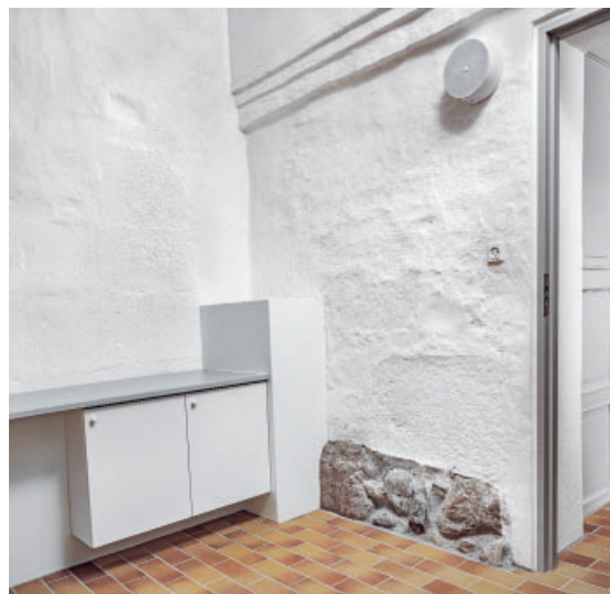
Fig. 25. Våbenhusets vestmur og skibets sydmur set fra dåbsventeværelset (s. 4172). Foto Arnold Mikkelsen 2023. – The west wall of the porch and the south wall of the nave seen from the baptismal waiting room.
