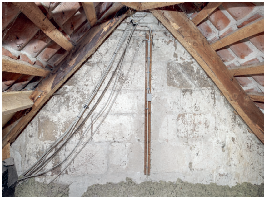
Fig. 82. Skibets sydmur set fra våbenhusloftet (s. 4181). Foto Arnold Mikkelsen 2023. – The nave's south wall seen from the loft of the porch.
