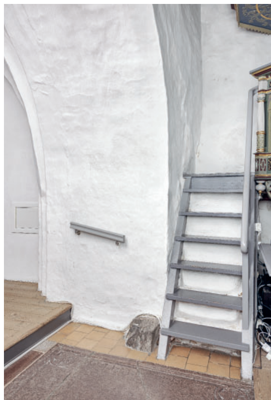
Fig. 22. Kvadersten fra den oprindelige korbue (s. 4167) samt muret trappeopgang i skibets sydøstre hjørne (s. 4173). Foto Arnold Mikkelsen 2023. – Ashlar from the original chancel arch, and masonry stairway in the south east corner of the nave.
