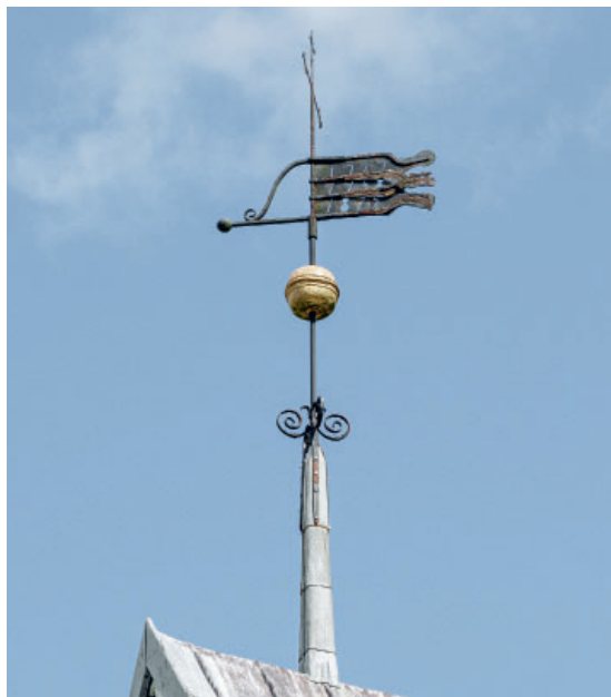
Fig. 29. Tårnets vindfløj (s. 4250). Foto Arnold Mikelsen 2023. – The weather vane of the tower.
