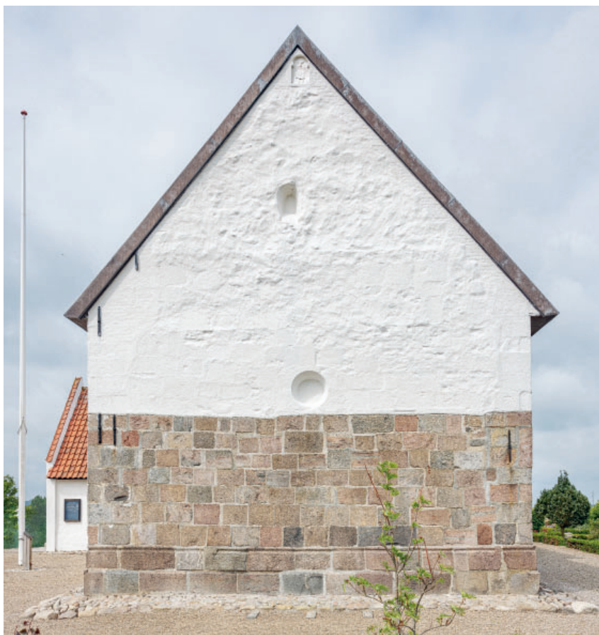
Fig. 24. Korets østgavl (s. 4236). Foto Arnold Mikkelsen 2023. – The east gable of the chancel.
