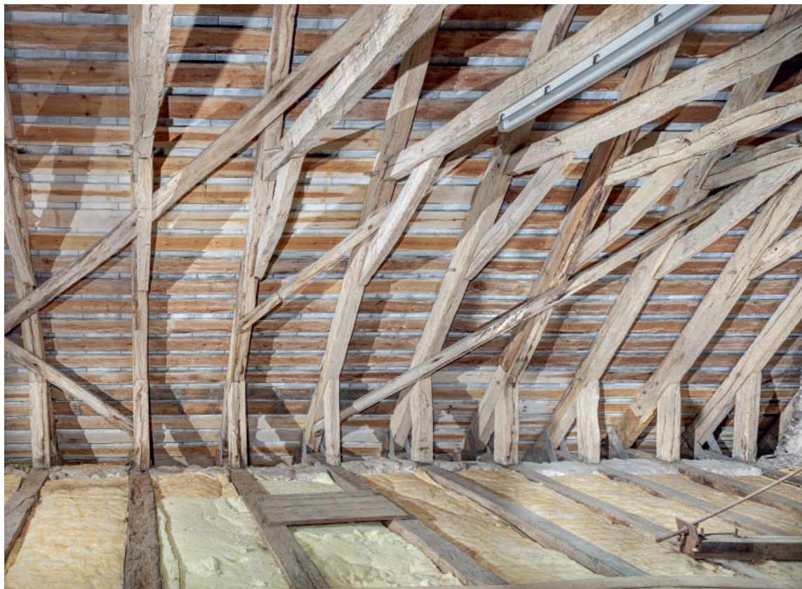
Fig. 25. Udsnit af skibets tagværk set mod nord (s. 4248). Foto Arnold Mikkelsen 2023. – Part of the roof structure of the nave looking north.
