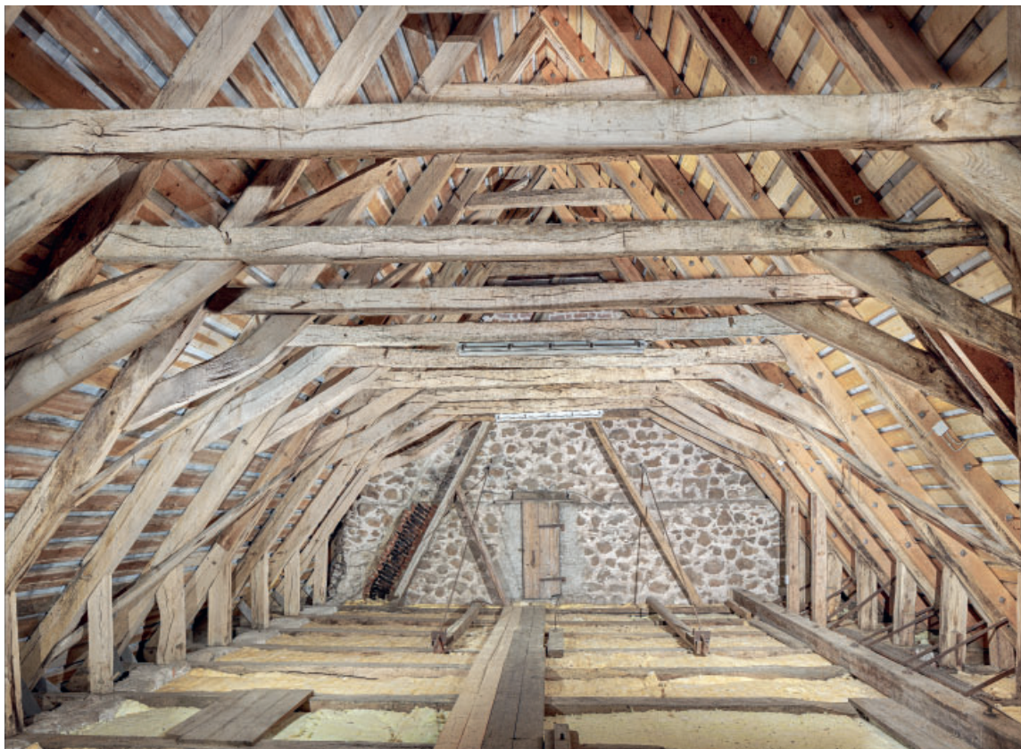
Fig. 26. Skibets tagværk, rejst i 1400-tallets første årti, set mod øst (s. 4248). Foto Arnold Mikkelsen 2023. – The roof structure of the nave, first decade of the 15th century, looking east.
