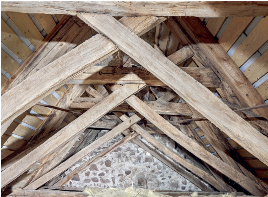
Fig. 27. Udsnit af korets tagværk, 1400-tallets midte, set mod øst (s. 4248). Foto Arnold Mikkelsen 2023. – Part of the roof structure of the chancel, mid-15th century, looking east.
