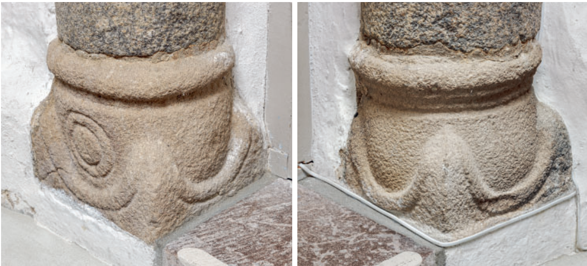
Fig. 17-18. Skibets sydportal. 17. Vestre søjlebase (s. 4238). 18. Østre søjlebase (s. 4238). Foto Arnold Mikkelsen 2023. – The south portal of the nave. 17. Western column base. 18. Eastern column base.
