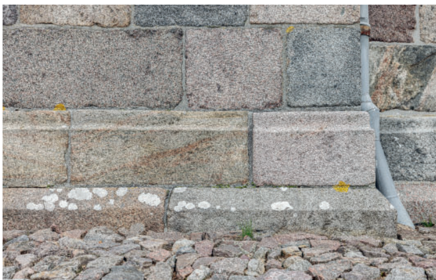
Fig. 6. Skibets sydøstre hjørnesokkel (s. 4297). Foto Arnold Mikkelsen 2023. – The southeastern corner plinth of the nave.
