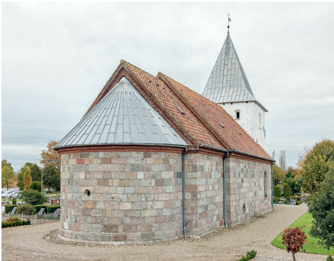
Fig. 12. Ydre set fra nordøst. Foto Arnold Mikkelsen 2023. – The exterior seen from the northeast.
