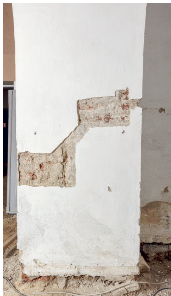
Fig. 47. Tårnarkadens søndre vange med delvist afhugget puds (s. 4293). Foto Arnold Mikkelsen 2024. – The southern jamb of the tower arcade with partially removed plaster.
