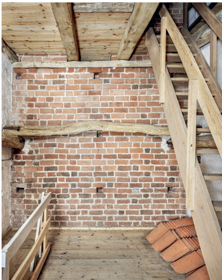
Fig. 9. Tårnets mellemstokværk set mod nord (s. 4292). Foto Arnold Mikkelsen 2023. – The middle floor of the tower looking north.
