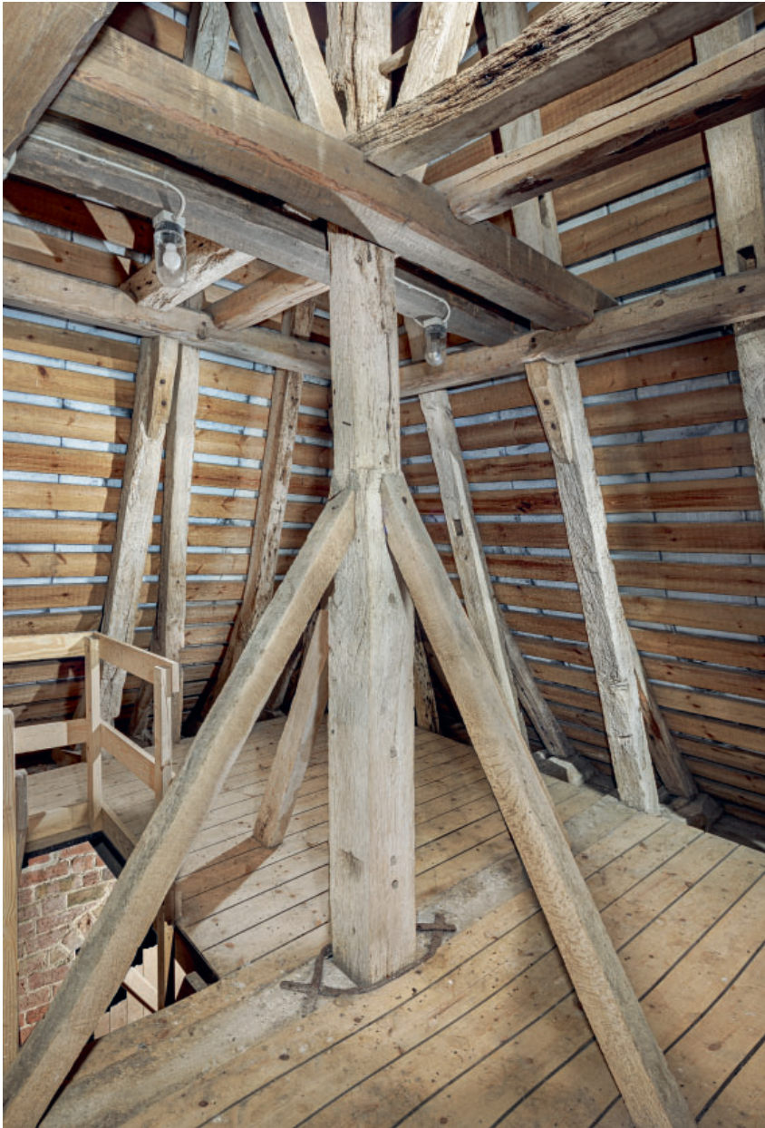
Fig. 10. Tårnets tagkonstruktion set mod nordøst (s. 4300). Foto Arnold Mikkelsen 2023. – The roof construction of the tower looking northeast.
