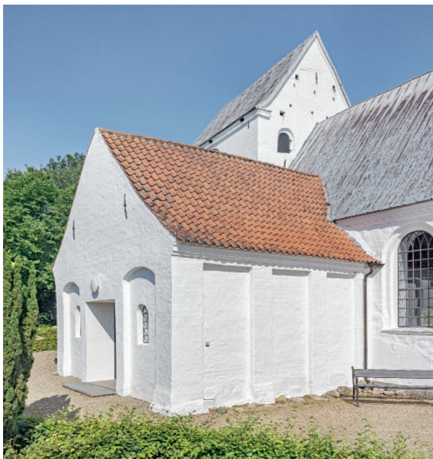
Fig. 10. Våbenhuset set fra sydøst (s. 4339). Foto Arnold Mikkelsen 2023. – The porch seen from the southeast.
