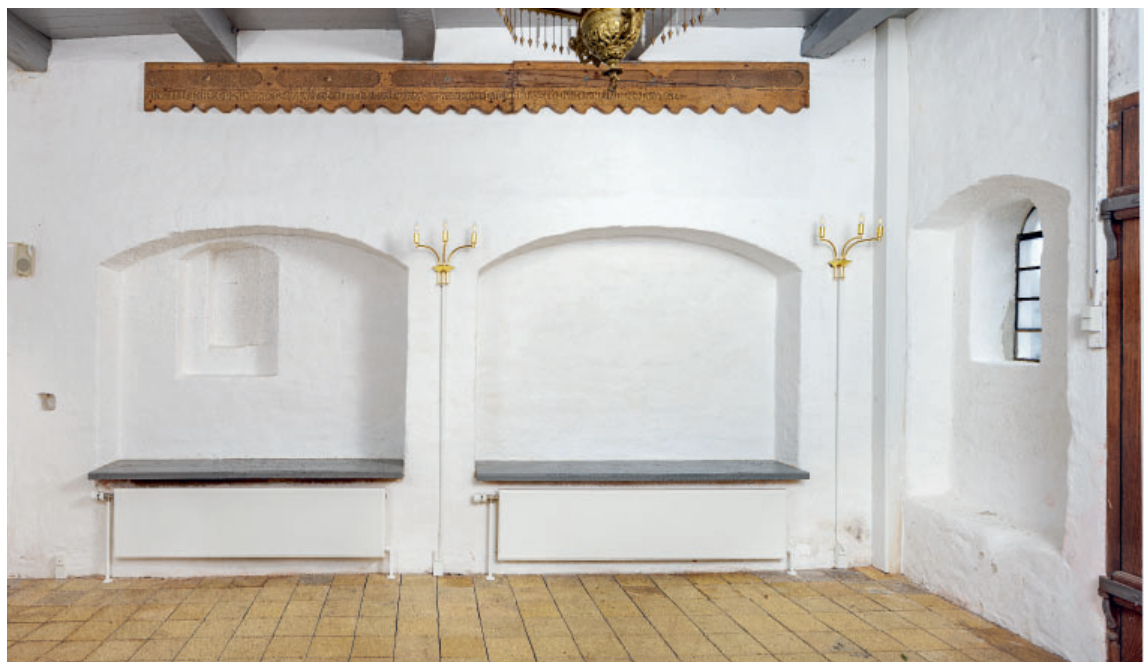
Fig. 11. Våbenhusets indre set mod øst (s. 4339) med del af (†)pulpitur 1686 (s. 4361). Foto Arnold Mikkelsen 2023. – The interior of the porch looking east with fragment from (†)gallery, 1686.
