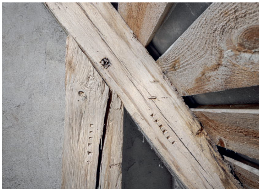
Fig. 17. Udsnit af korets tagværk, o. 1440, set mod vest (s. 4345). Foto Arnold Mikelsen 2023. – Part of the roof structure of the chancel, c. 1440, looking west.
