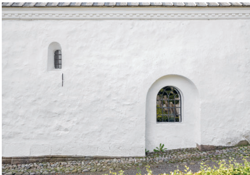
Fig. 8. Udsnit af skibets nordmur (s. 4336). Foto Arnold Mikkelsen 2023. – Section of the north wall of the nave.
