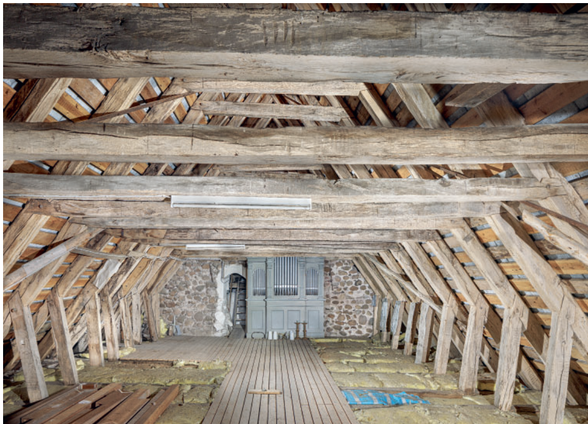
Fig. 14. Skibets tagværk set mod vest (s. 4345). Foto Arnold Mikkelsen 2023. – The roof structure of the nave looking west.
