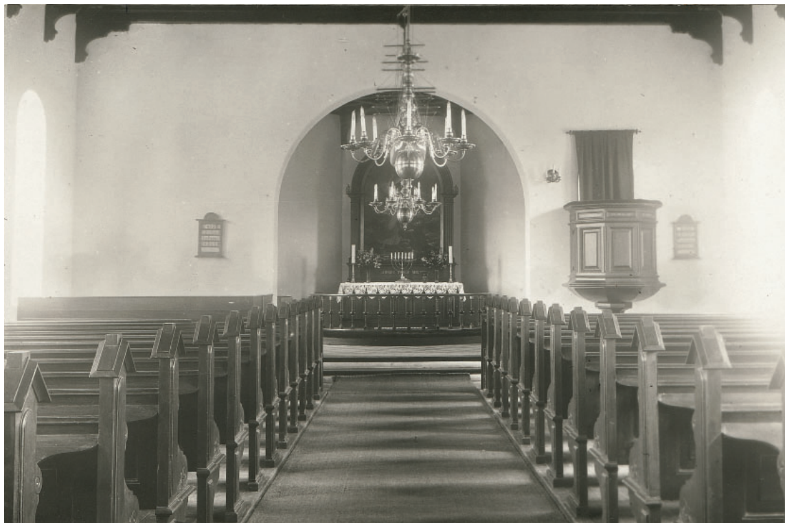
Fig. 11. Indre set mod øst. Ældre foto, i NM. – The interior looking east.
