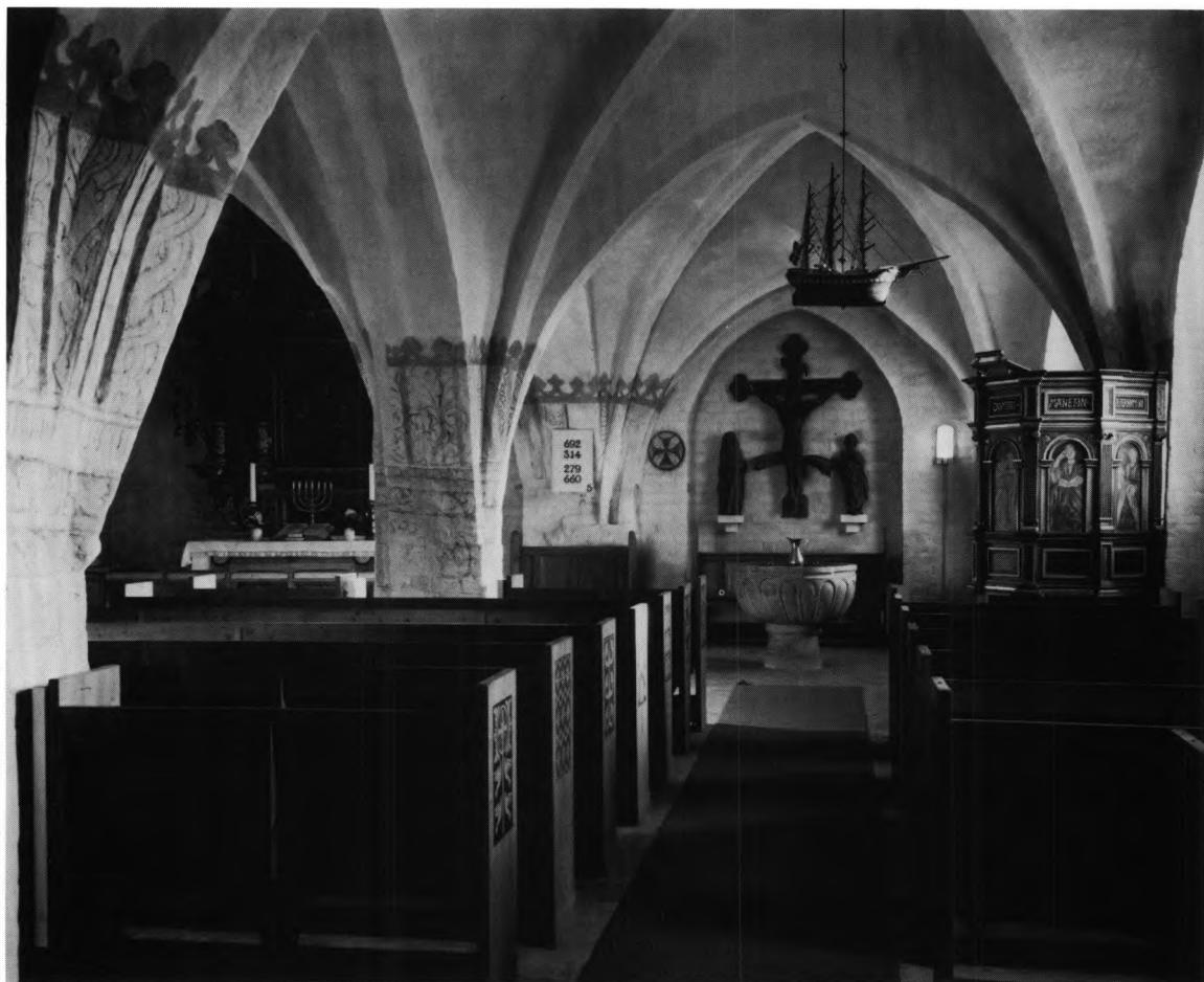
Fig. 11. Indre, set mod øst. NE fot. 1979. - Interior to the east.
