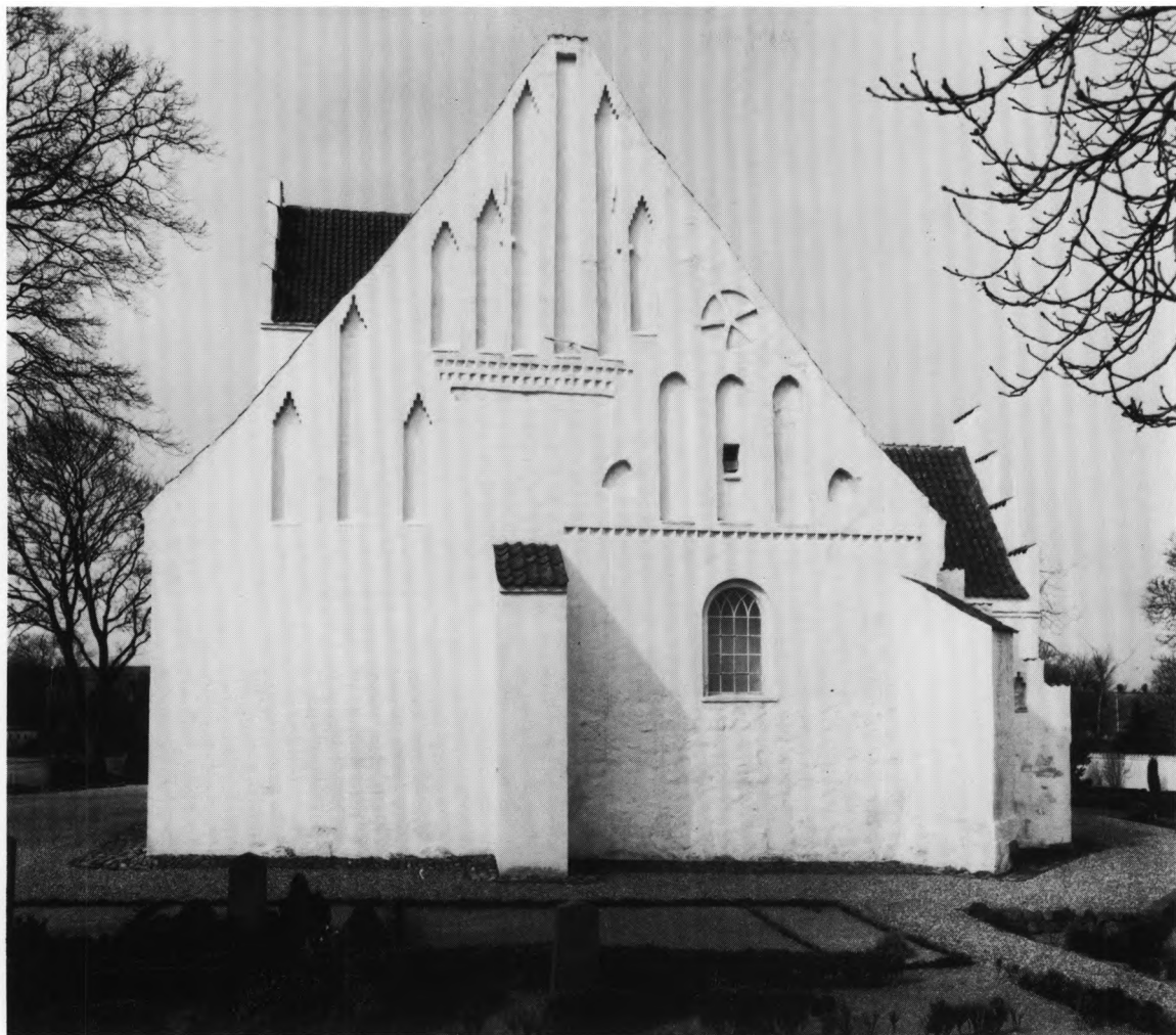
Fig. 10. Kirkens østgavl, bestående af to selvstændige gavle, en ældre mod nord o. 1375-1400 (s. 1301) og en yngre mod syd o. 1500 (s. 1307), der herefter er bygget sammen til en helhed o. 1525 (s. 1308). HJ fot. 1985. - East gable of the church comprising two separate gables, the earlier one to the north (c. 1375-1400), and the later one to the south (c. 1500). Both these gables were then rebuilt as one gable c. 1525.
