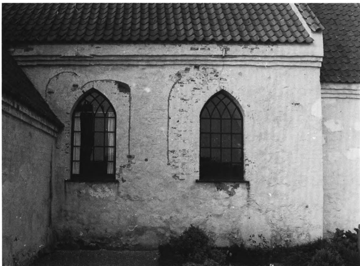
Fig. 11. Skibets sydmur med spor af ældre vinduer. Fot. i NM2 fra o. 1973, da kirken restaureredes. - The south wall of the nave showing traces of former windows.
