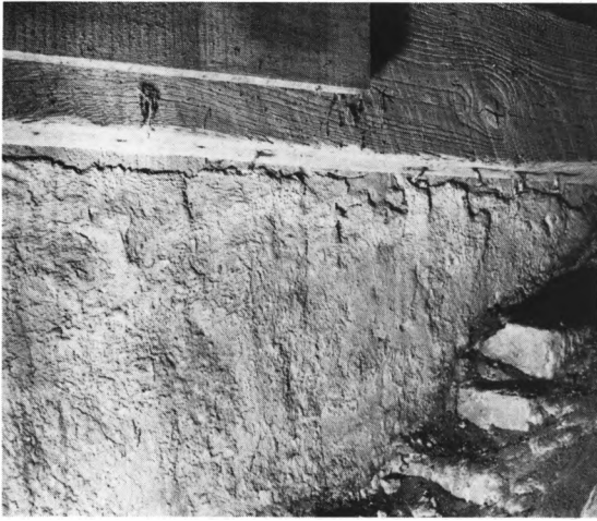
Fig. 6. Bjælke langs triumfvæggen, set fra skibets loft. På undersiden ses søm, hvormed det oprindelige \ddot{r} bræddeloft har været fastgjort (s. 1351). HJ fot. 1985. - Beam along the east wall of the nave, seen from the loft. The under side still shows some of the nails used for fastening the original tboard ceiling.
