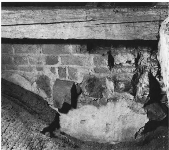
Fig. 5. Det romanske skibs murkrone i nord med ende af oprindelig loftsbjælke, som afhuggedes med økse ved hvælvslagningen (s. 1446). HJ fot. 1985. - Crown of the north wall of the Romanesque nave, revealing end of original beam, cut off with axe when the vaults were put up.
