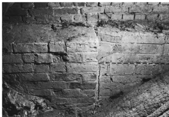
Fig. 8a-b. Sammenbygningen af skibets og vestforlængelsens mure, set fra loftsrummet (s. 1448). - Over den oprindelige murkronen (angivet med stiplede linjer) ses yngre forhøjelser (s. 1450). a. Nordmuren. b. Sydturen. HJ fot. 1985. - The junction between the walls of the nave and the west extension, seen from the loft. Above the original crown of wall (indicated by dotted lines) are the later heightened parts. a. North wall. b. South wall.
