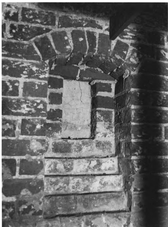
Fig. 16. Oprindelig vinduesniche i underetagen af nordre tilbygning, jfr. fig. 18a (s. 1453). KdeFL fot. 1965. - Original window recess in the lower storey of the north chapel, cf. fig. 18a.
