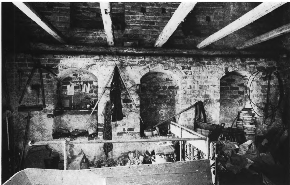
Fig. 20. Sydsidens våbenhus, mens det benyttedes som material- og fyrrum. Indre, set mod vestvæggen med bjælker mellem de to stokværk (s. 1457). Marinus Andersen fot. o. 1963. - The south porch when used as toolshed and boiler room. Interior to the west showing the beams between the two storeys.
