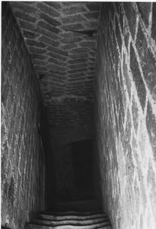
Fig. 14. Trappeløb i tårnets nordmur, set mod underdør til skibet (s. 1451). HJ fot. 1985. - Stairs in the north wall of the tower seen towards the entrance from the nave.
