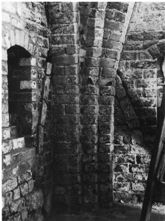
Fig. 17. Nordøstre hjørne af nordre tilbygnings stueetage med levn af oprindelig kamin bag sekundære hvælpiller, sml. fig. 18a (s. 1453). Marinus Andersen fot. 1965. - North-east corner of the lower storey of the north chapel showing remains of fireplace behind the secondary pillars of the vault, cf. fig. 18a.
