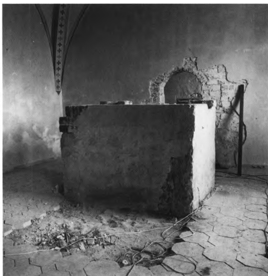
Fig. 61. Senmiddelalderligt alterbord, foruden af kampesten, foroven af mursten. Fotograferet under restaureringen 1964-67 (s. 1465). KdeFL fot. 1965. - Late medieval altar with base of boulders and bricks above.
