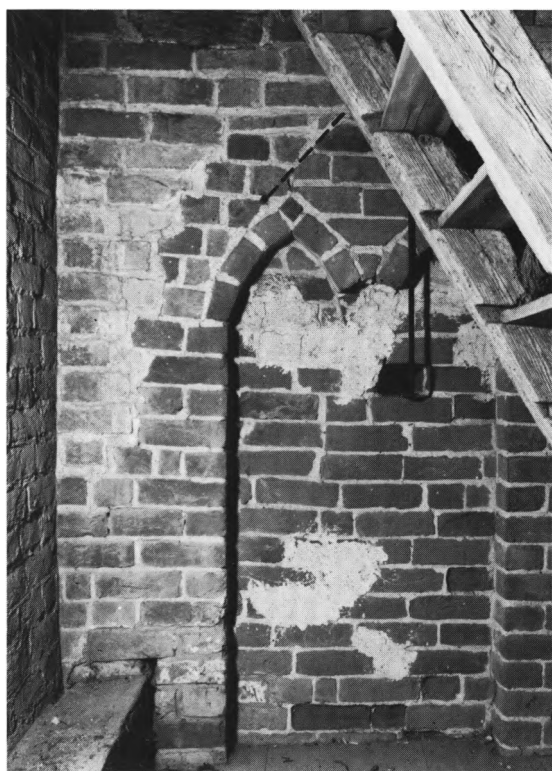
Fig. 9. Detalje af vestforlængelsens gavl, set fra tårnets øvre mellemstokværk, sml. fig. 10 (s. 1448). Bemærk levn af sekundær kam over den oprindelige skrå taglinje, angivet med stiplede linje (s. 1450). HJ fot. 1985. - Detail of the west extension's gable, seen from the upper middle storey of the tower, cf. fig. 10. Notice remains of secondary crest above the original side of the sloping roof, indicated by dotted line.
