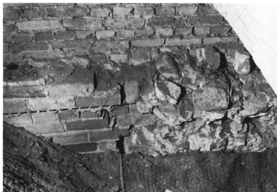
Fig. 8a-b. Sammenbygningen af skibets og vestforlængelsens mure, set fra loftsrummet (s. 1448). - Over den oprindelige murkronen (angivet med stiplede linjer) ses yngre forhøjelser (s. 1450). a. Nordmuren. b. Sydturen. HJ fot. 1985. - The junction between the walls of the nave and the west extension, seen from the loft. Above the original crown of wall (indicated by dotted lines) are the later heightened parts. a. North wall. b. South wall.
